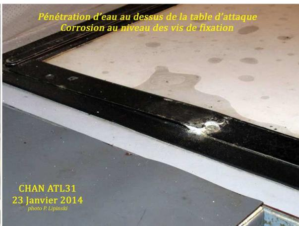
*La table d'attaque est retrouvée pleine d'eau avec une forte corrosion au niveau d'une des vis de fixation*
